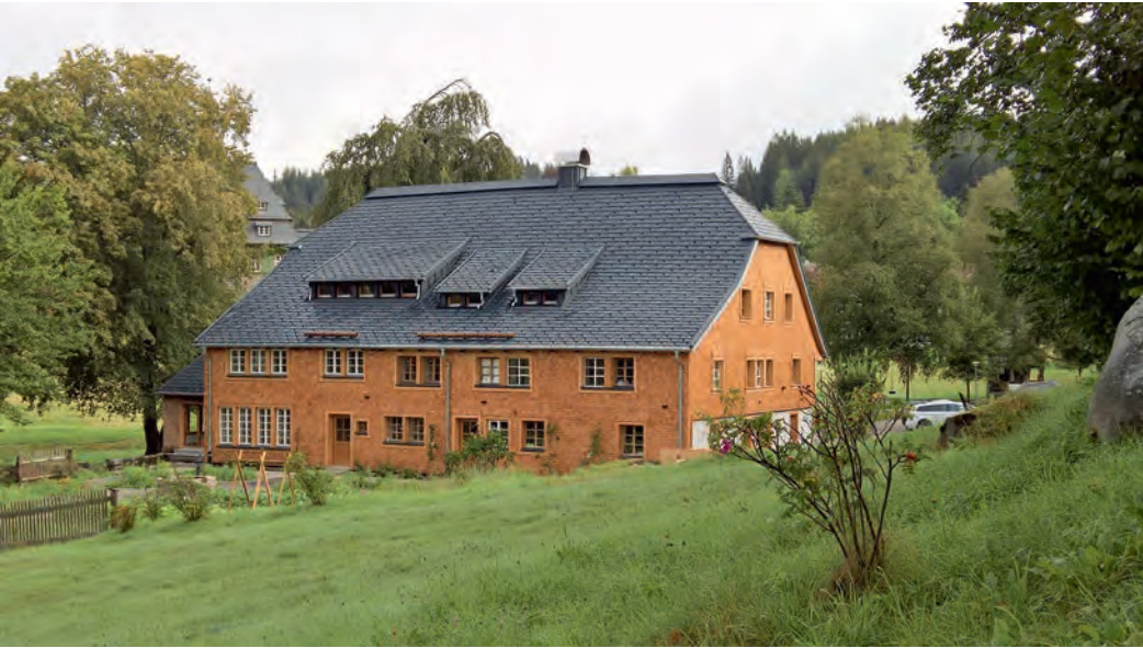
Der Altbirklehof stand lange leer und war vom Verfall bedroht. Die Sanierung sorgt für den Erhalt und die Wiederbelebung des denkmalgeschützten Schwarzwaldhofs. Neben Wohnraum entstanden auch Räume, die künftig für öffentliche kulturelle Veranstaltungen genutzt werden können.
